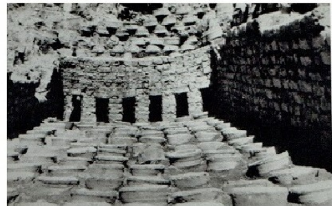
図 16 龍泉県石大門Y16号元代窯址の奥壁排煙孔の状況
