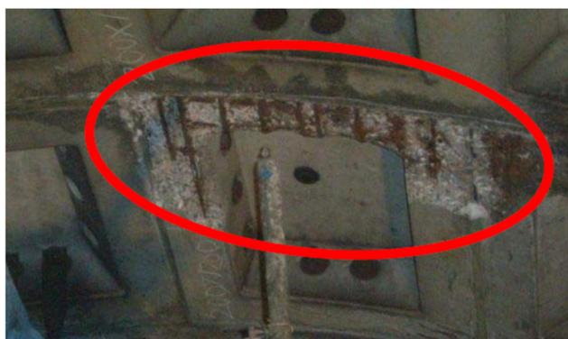
写真6-4-1 打音判定A箇所の例（はつり後）
