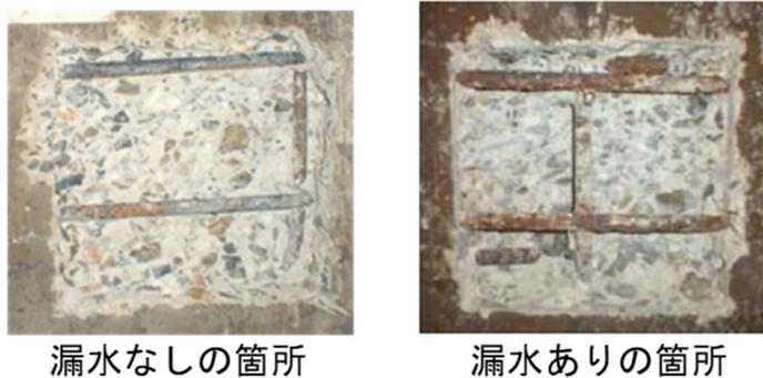
写真 3-3-1 鉄筋腐食状況の比較<sup>2)</sup>
