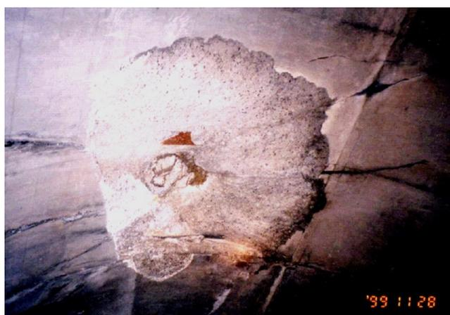
写真2-2-4 礼文浜トンネルのはく落跡<sup>17)</sup>
