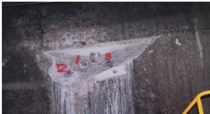
写真 2-2-1 福岡トンネルのはく落跡<sup>17)</sup>
