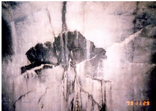
写真 2-2-7 礼文浜トンネルのはく落箇所付近のひび割れ状況
