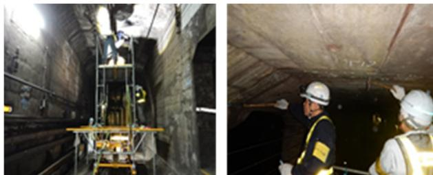
写真7-3-1 全面打音検査状況
