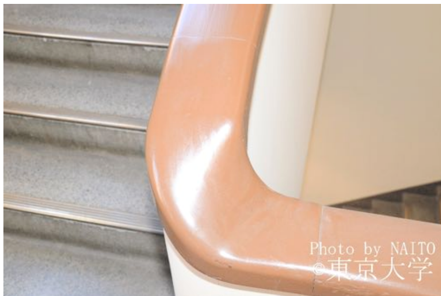
写真 33 東京大学医学部附属病院内科研究棟階段部手摺
