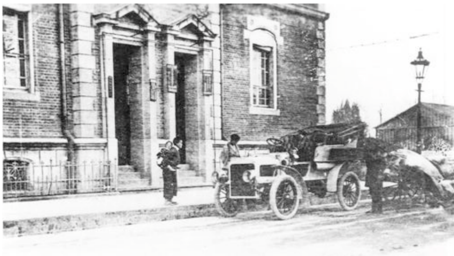
写真 20 三菱一号館エントランス[三菱地所所蔵]
