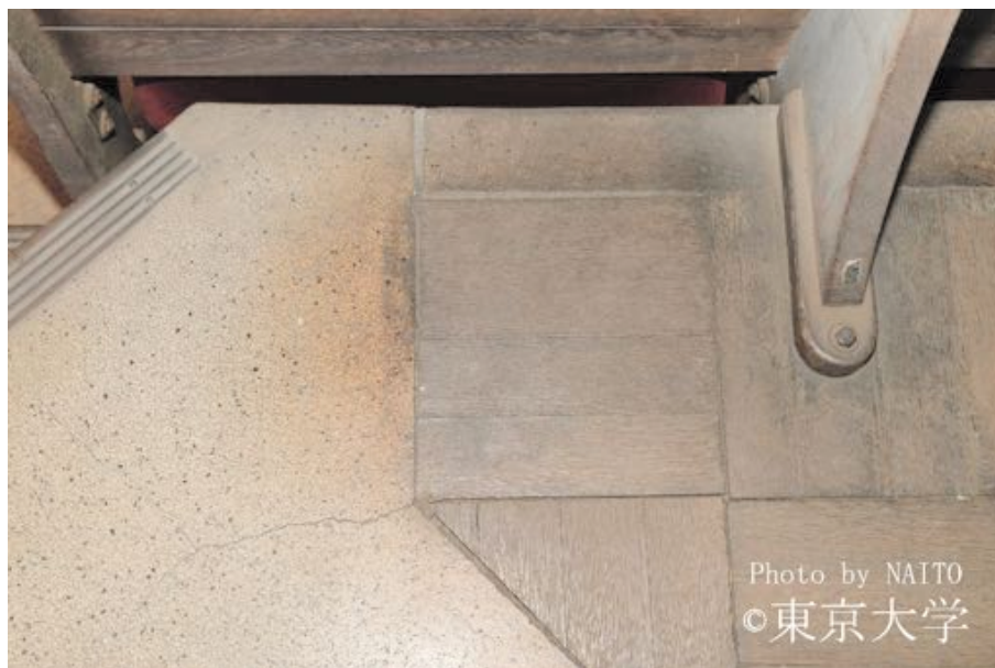
写真 39 東京大学医学部附属病院内科研究棟内科講堂内科講堂床部分
