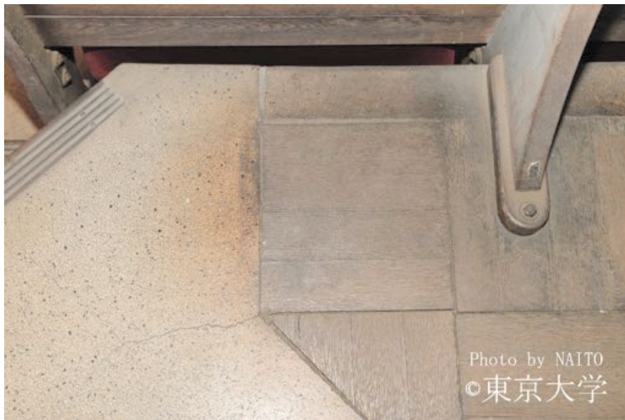
写真 30 東京大学医学部附属病院内科研究棟内科講堂内科講堂床部分
