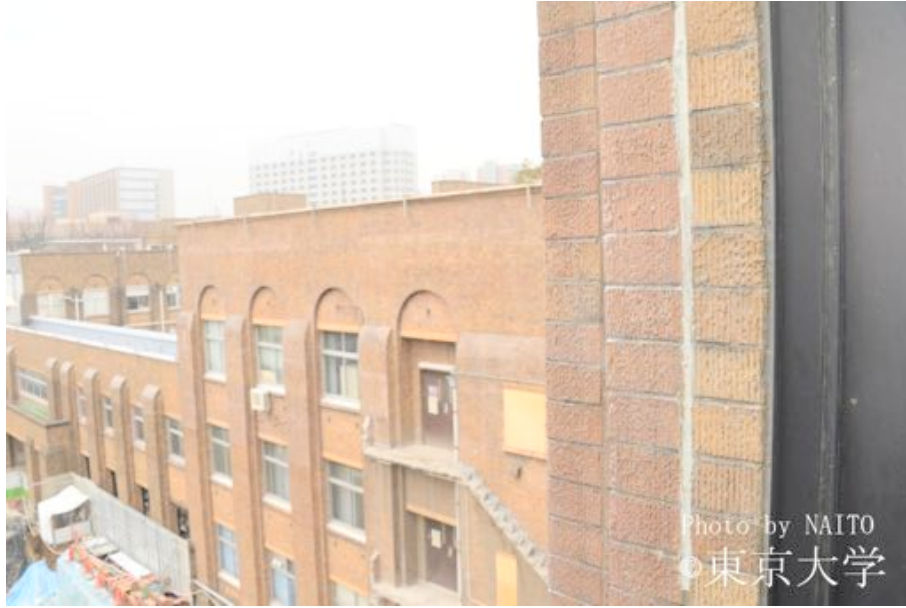
写真 36 東京大学医学部附属病院内科研究棟外壁
