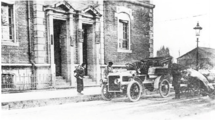
写真 38 三菱一号館エントランス[三菱地所所蔵]
