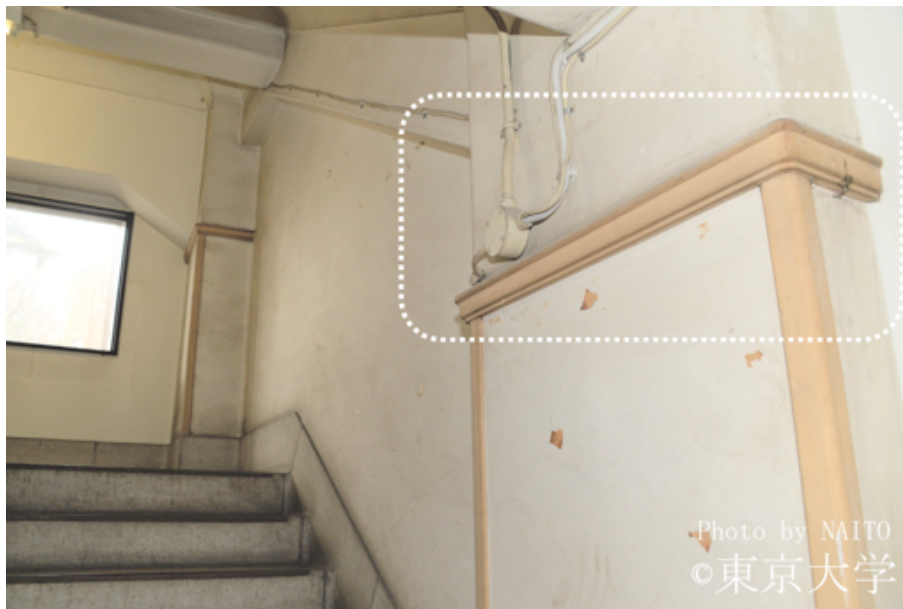
写真 41 東京大学医学部附属病院内科研究棟壁面部分
