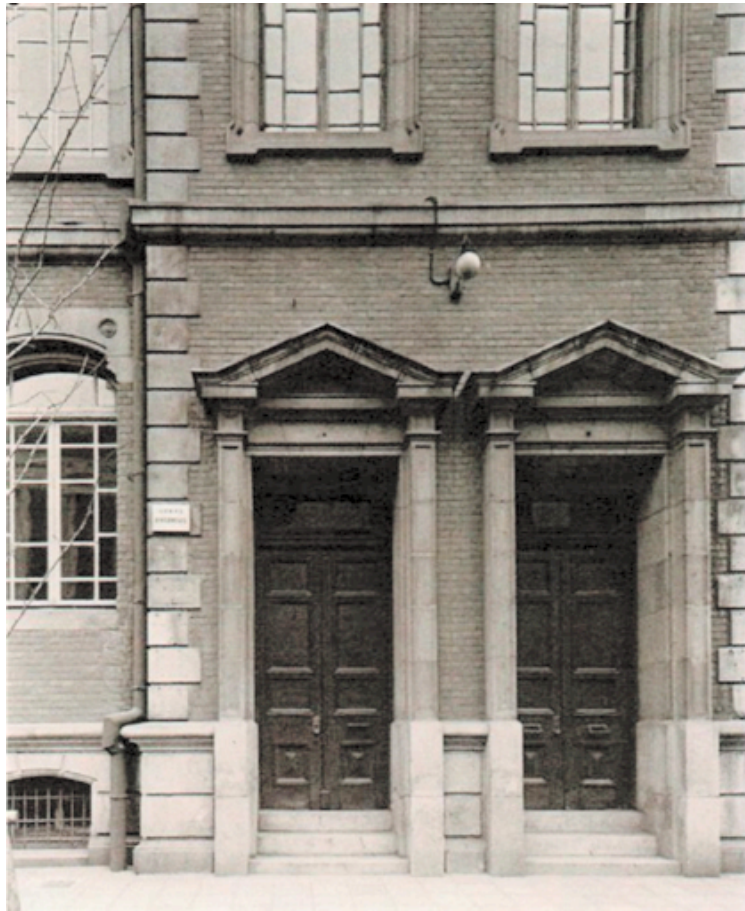
写真 21 三菱一号館エントランス[三菱地所所蔵]
