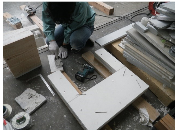
(4) 炉蓋 セラミックボード接着・ビス止め
