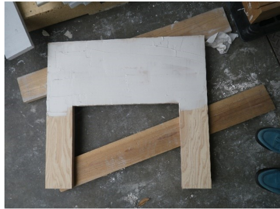
(2) 炉蓋 繊維混入けい酸カルシウム板接着
