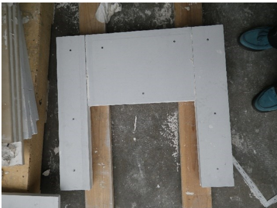
(3) 炉蓋 繊維混入けい酸カルシウム板ビス止め
