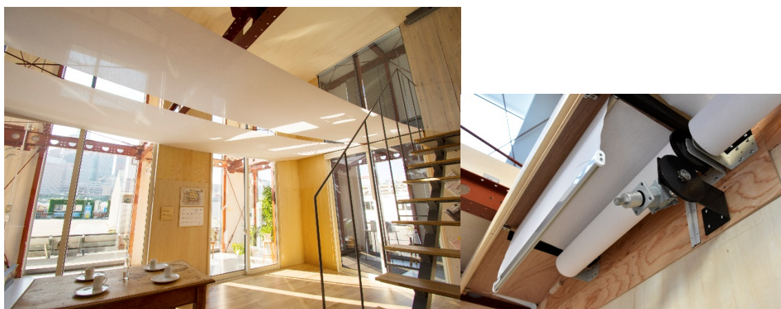
図 6-10 可動式水平膜 (左：可動式水平膜, 右：巻き付けロール)
