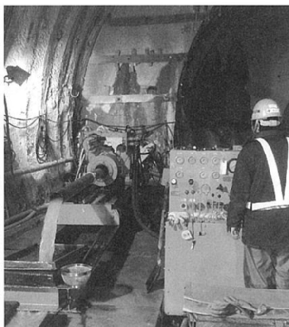
図 3-13 シールドドリバース工法による削孔状況 23)
