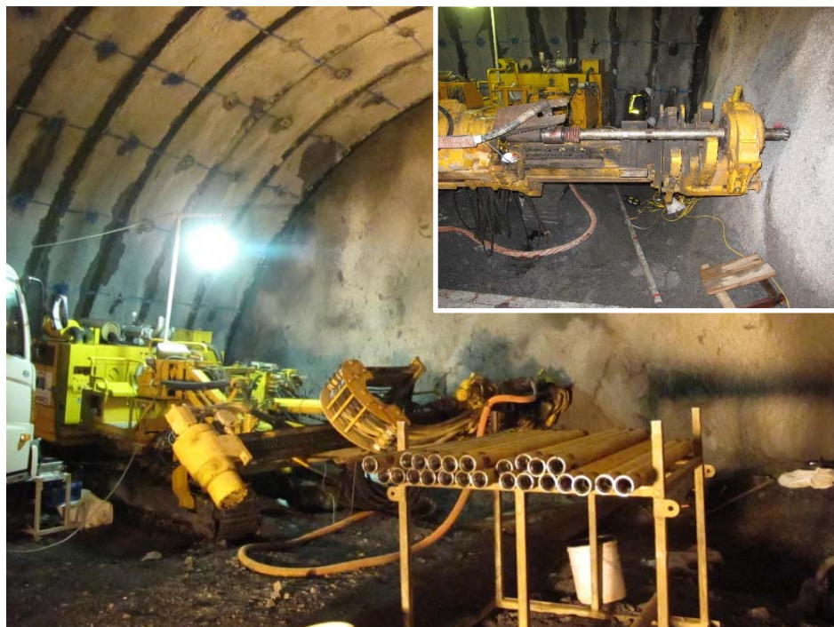
写真 3-2 水圧ハンマー工法による削孔状況
