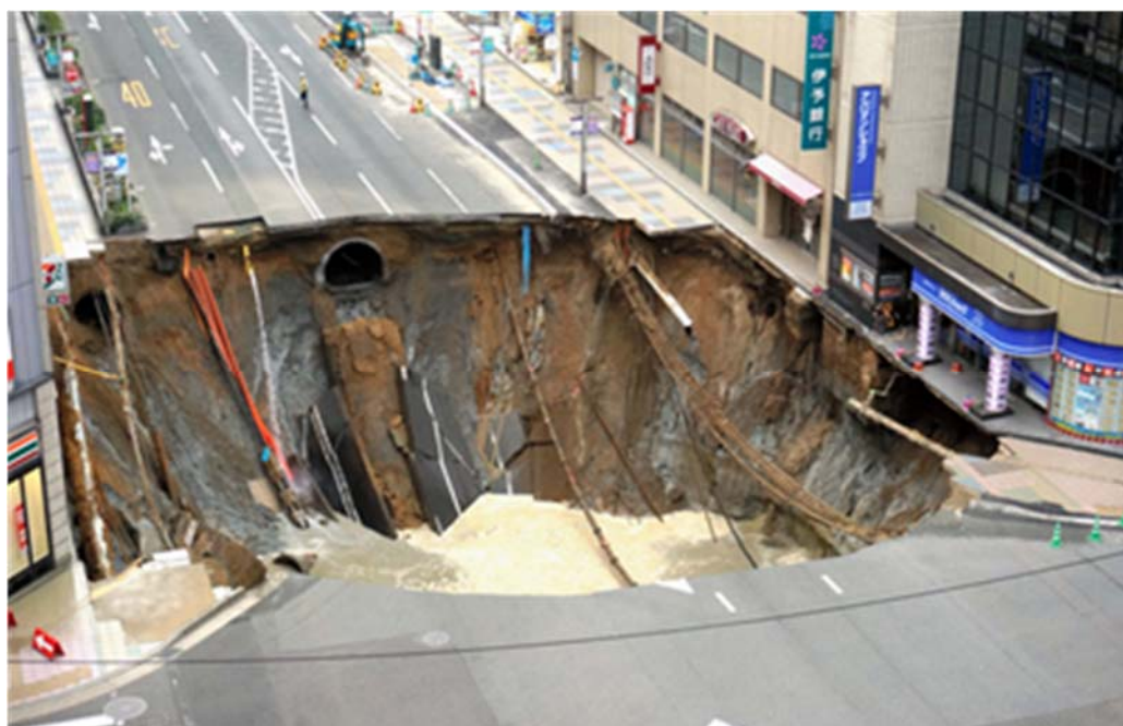
図 2-22 陥没後の写真 16)
