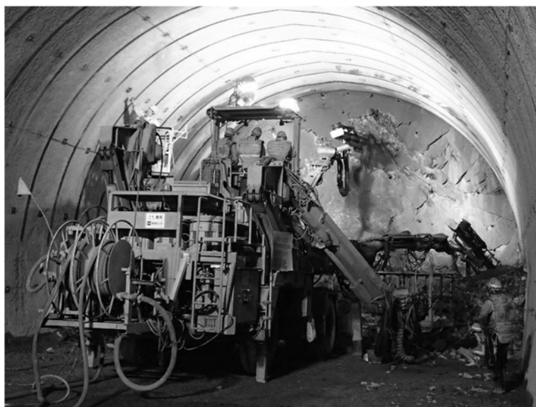
写真 3-1 ドリルジャンボに搭載された削岩機による削孔状況
