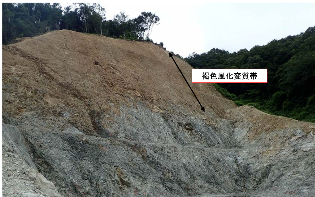
図 2-12 脆弱な風化変質帯の例（採石場：1 ベンチの高さ 5m）
