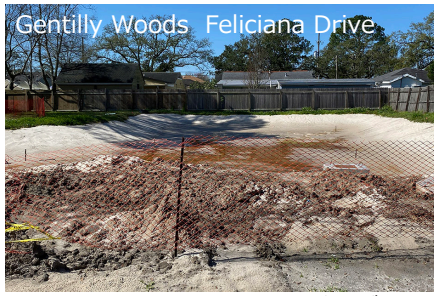
写真2-3 NGIによるレインガーデン (建設中)
