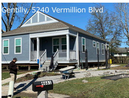
写真2-1 CAPによる前庭の再舗装
