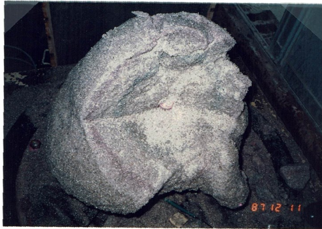
写真-4-2 瞬結性薬液注入での良好な固結形状②
