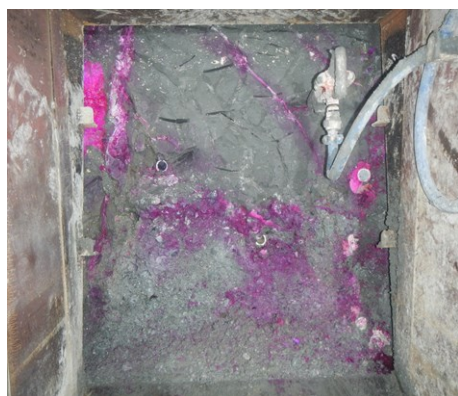
写真-6-1 注入後の固結状態①
