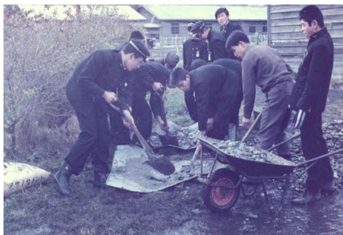
生徒と教員による校門の基礎工事 1970（昭和45）年
