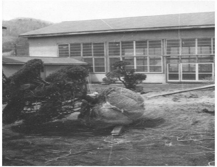
閉校前に根巻きされた庭木 1970（昭和45）年
