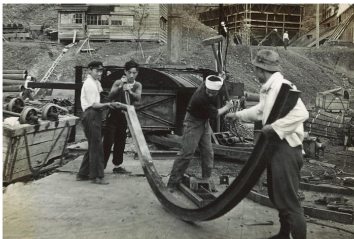
鉄工所で鋼枠を作る住谷氏（中央） 1955（昭和30）年ころ
