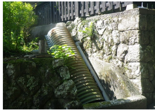
写真 2.3.4 暗渠化された場所(沢)
