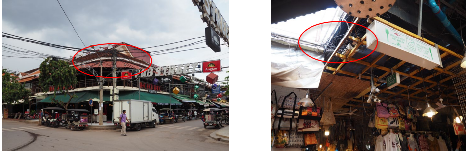
写真 4.6.1 看板と店舗内等にある電線の様子
