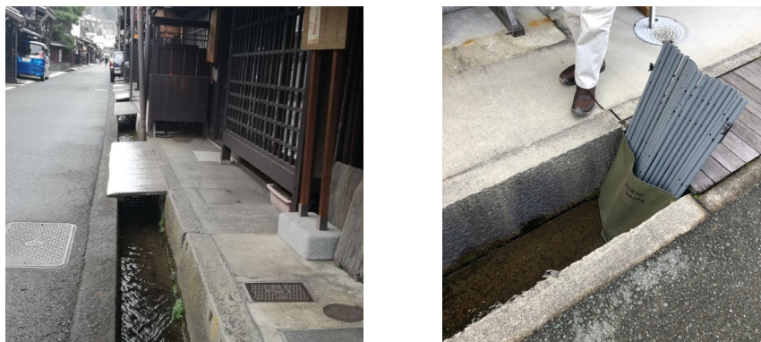
写真 3.2.3 道路両側にある水路と簡易水止め機材
