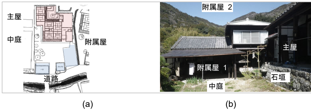
図 3.4.5 (a) 建物の配置 2,6) ; (b) 花沢地区の伝統的建造物の様子
