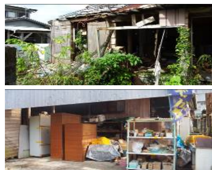
写真 3.5.2 空き家(上)と附属屋(下)
