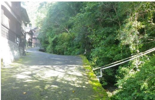
写真 2.3.5 道路拡張による川の急減部
