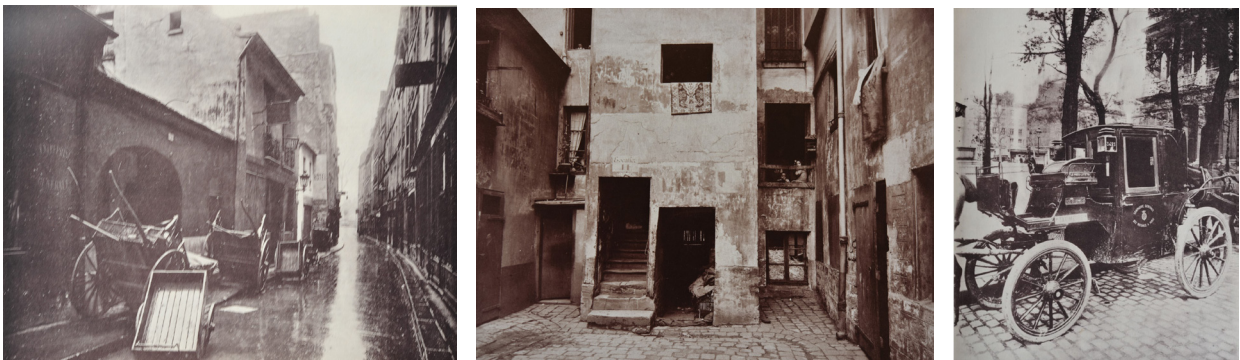
Fig.11 (L) Rue de Bièvre, (C) Courtyard, 41 Rue Broca (R) Voiture fiacre
