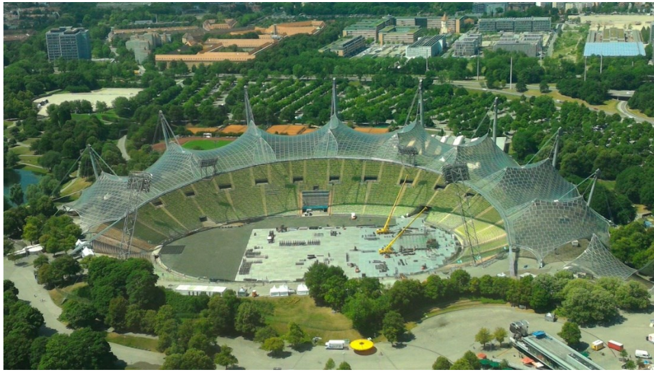
図 2 蜘蛛の巣状のテント風屋根を持つ五輪スタジアム＝ミュンヘンで 2017 年 7 月 18 日、著者撮影
