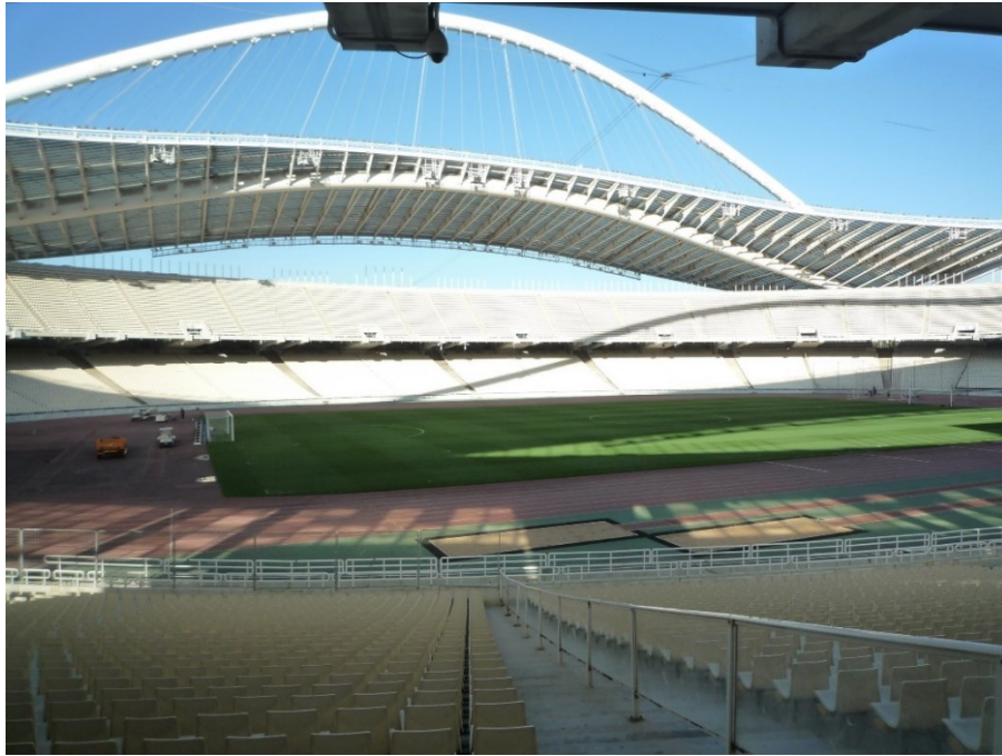
図 24 キールアーチ構造で陸上トラックも残る五輪スタジアム＝アテネで 2017 年 5 月 9 日、著者撮影
