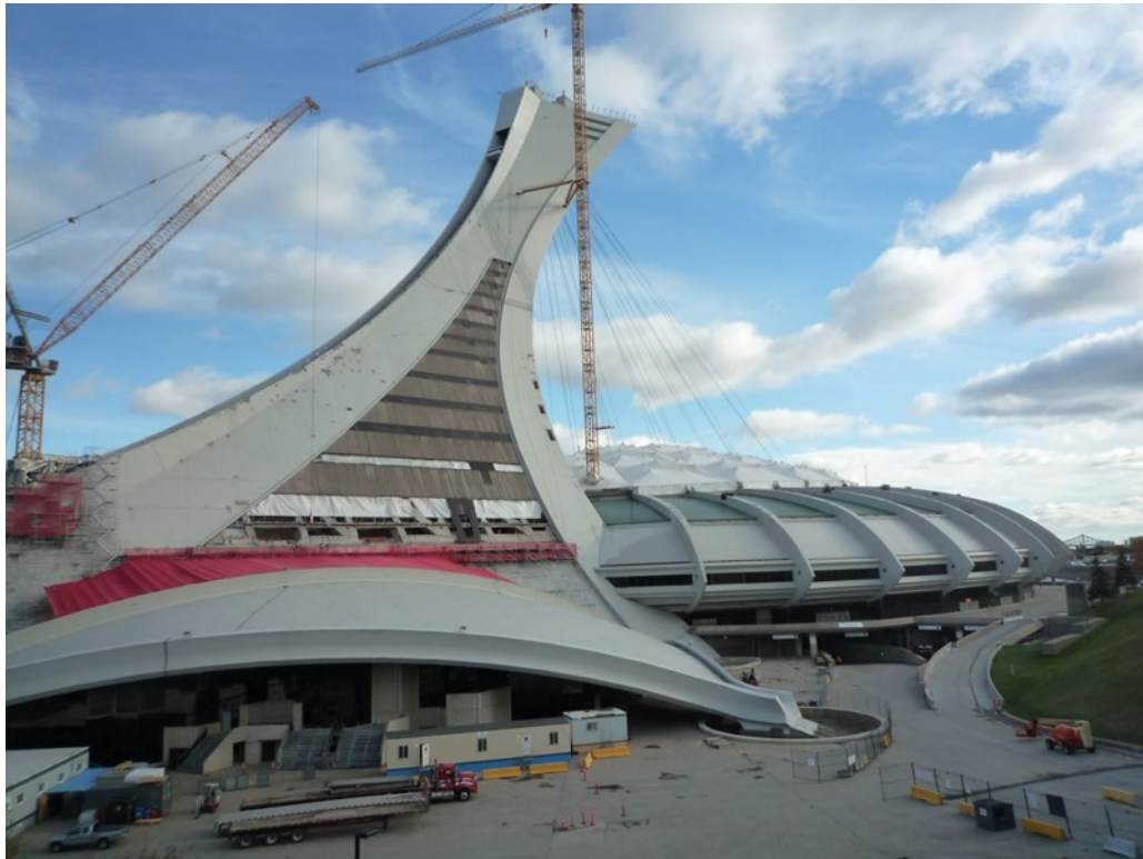
図7 大手金融機関デジャルダン・グループのオフィスをつくる工事が続く展望塔＝モン トリオール市で2016年11月3日、著者撮影
