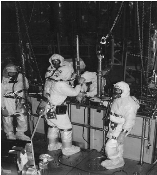
写真1 TMI-2のデブリ取り出し作業と取り出し用工具
