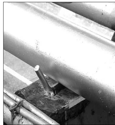
漏洩事故に繋がる危険物流体配管 運転中 外観目視+ラックスルー検査 停止時 吊り上げ検査+丸鋼ガイド
