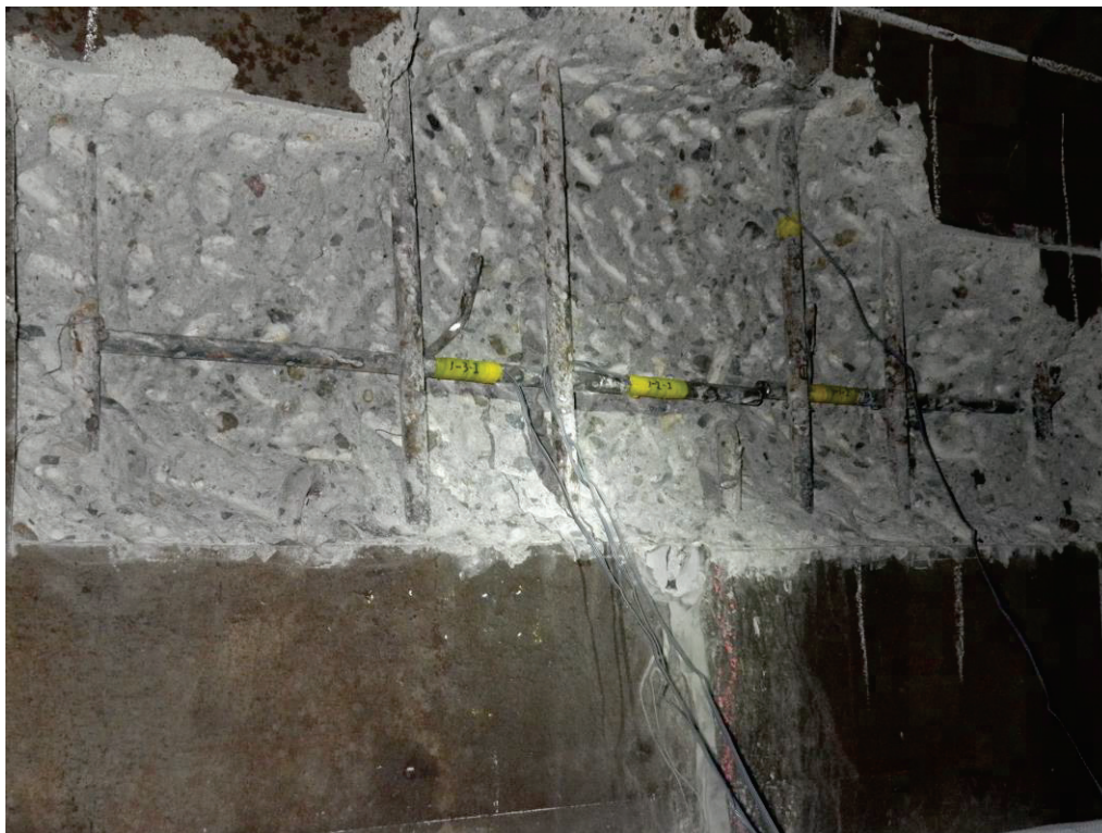
写真4-1-4 応力解放法（日比谷線，切断後の計測状況）
