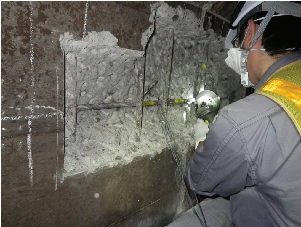
写真4-1-3 応力解放法（日比谷線，切断状況）
