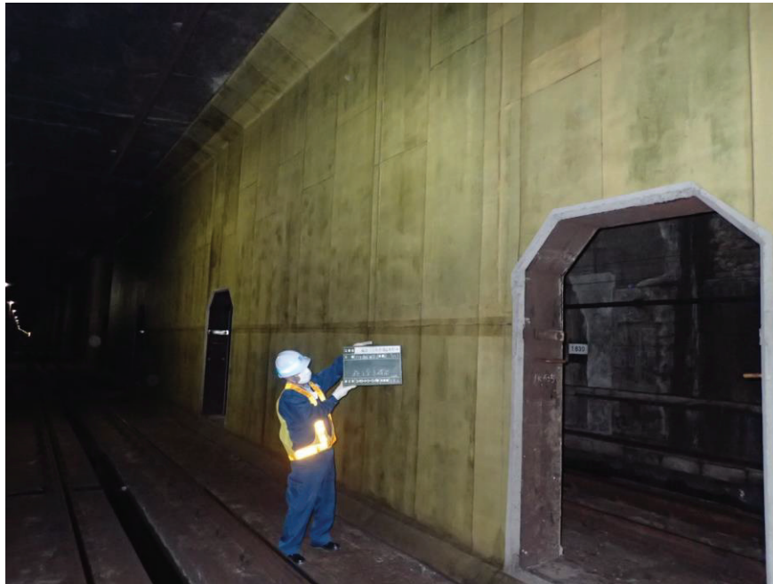
写真5-1-1 アラミド繊維シートによる補強工事後
