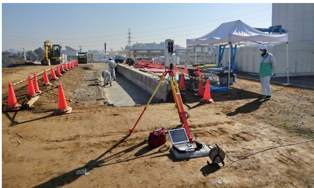
図 3.3-22 3D スキャナによる測量状況
