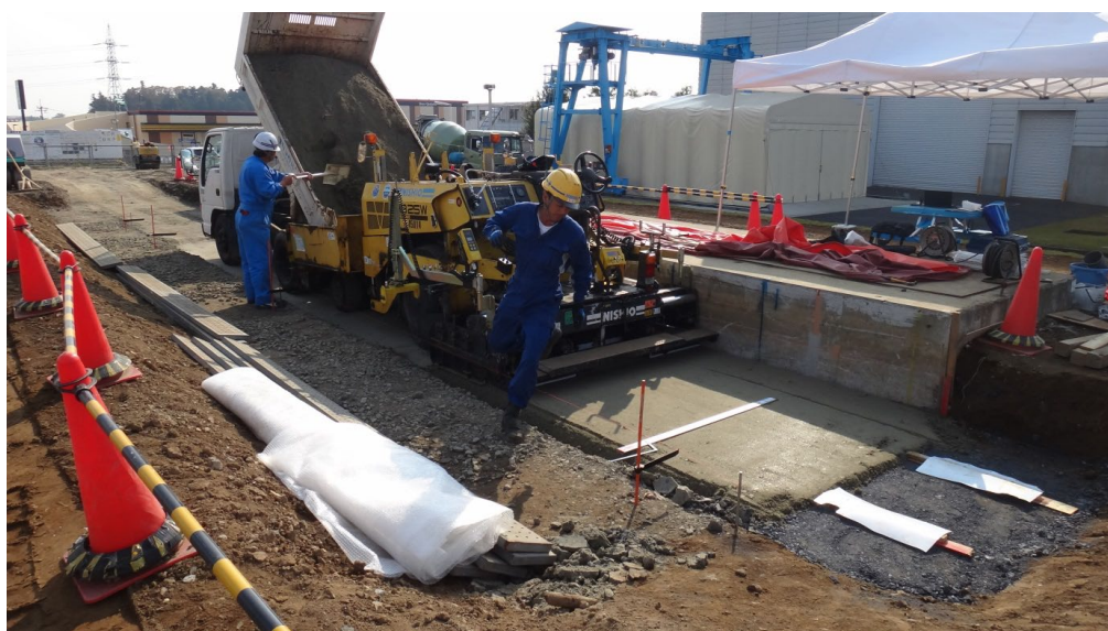
図 3.3-12 材料供給・敷均し状況
