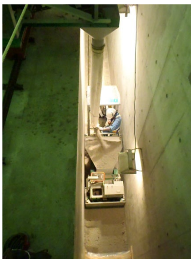
図 2.3-12 ベントナイト敷均し機への材料の供給状況
