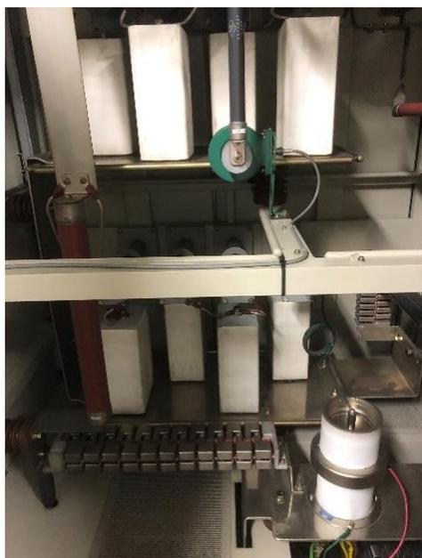
図 39 クライストロンモジュレータ内部. 右下に見えるのがサイラトロン
