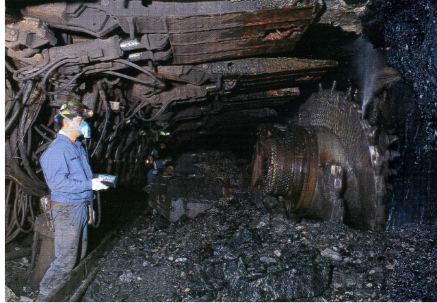
写真6-1 ドラムカッターのリモコン操作
