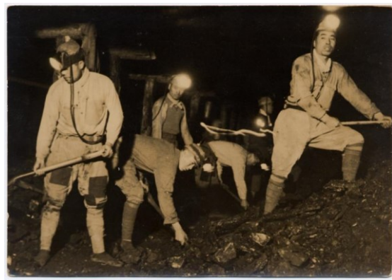
写真3-2 人力での採炭作業（1940年代） 出所：釧路市教育委員会太平洋炭砒資料室所蔵
