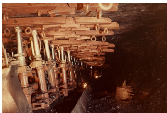
写真 3-7 沼尻完全機械化切羽（UU 枠） 出所：釧路市教育委員会太平洋炭礦資料室所蔵
