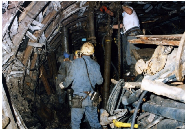
写真 6-4 落ち口前方での単柱を使用した山固め (1996 年 12 月撮影)
