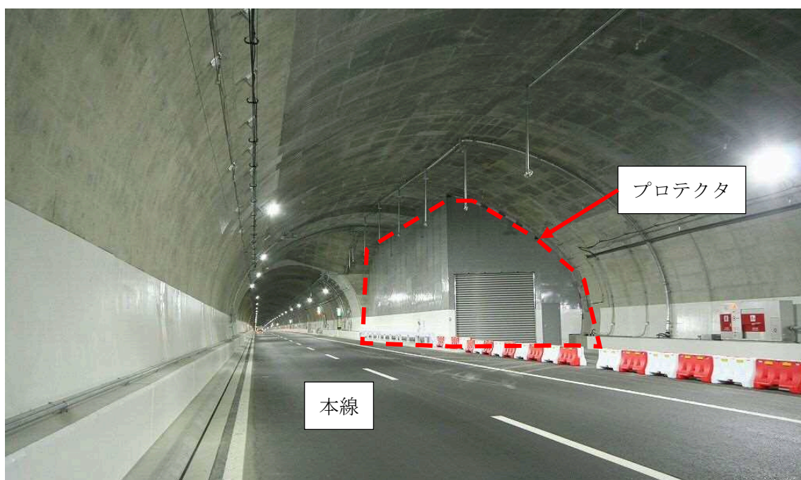
写真 3.4.6-1 プロテクタ設置状況
