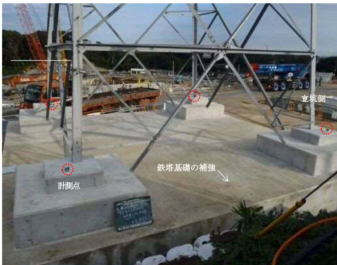
写真 3.1-2 鉄塔の補強状況
