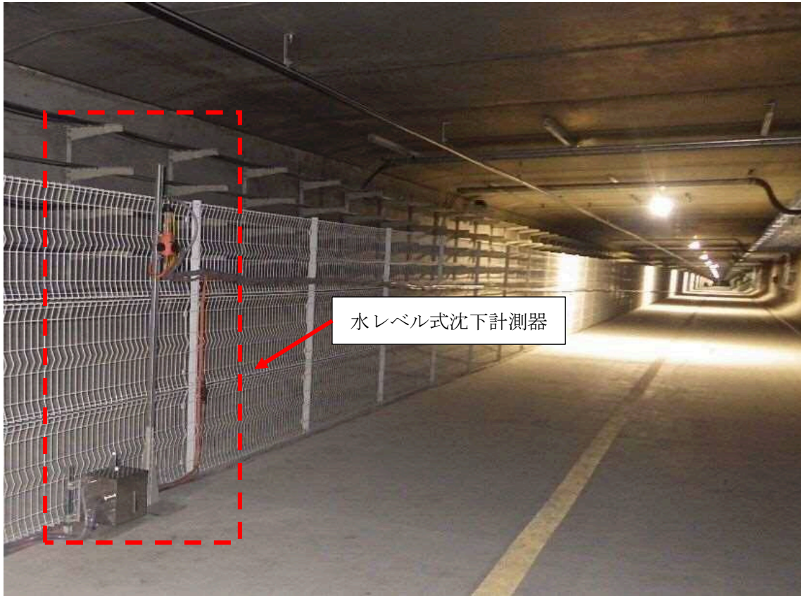
写真 3.4.6-5 本線トンネルインパート内における水レベル式沈下計測器設置状況
