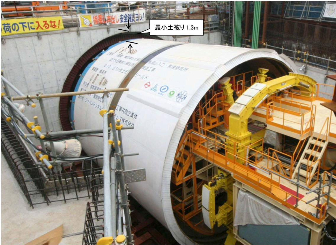
写真 3.1-1 B ランプシールド発進部の状況
