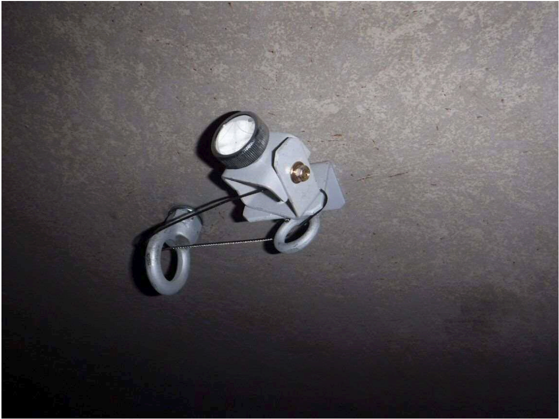
写真 3.4.6-4 本線トンネル内におけるプリズムの設置状況
