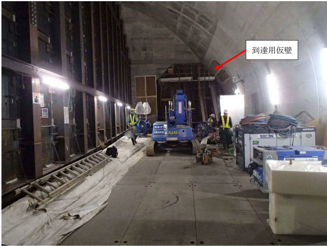
写真 3.4.6-2 プロテクタ内作業状況
