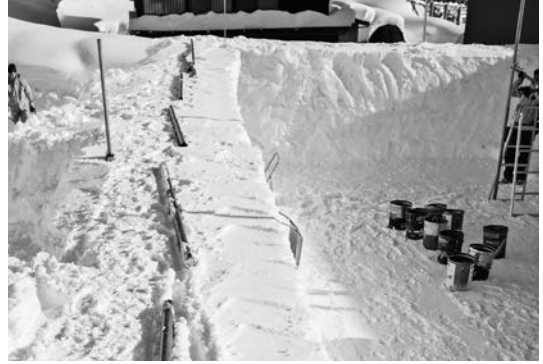
図5 組み上げに都合のいい位置へ運ばれた単管パイプ (2018年2月14日, 筆者撮影)
