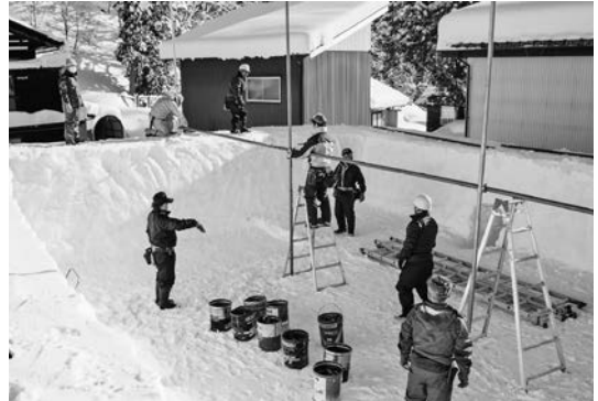
図7 運び出しを終えて単管パイプの組み上げに加わる (2018年2月14日, 筆者撮影)
