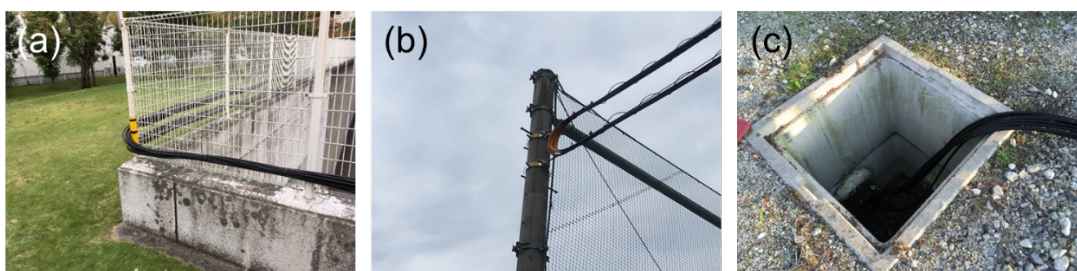
図A-3 SI型4CFケーブル敷設の外観図
