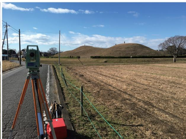
写真7 TSを用いたトラバース測量
